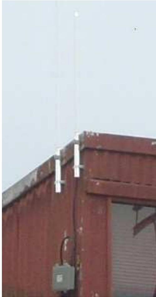
Fig. 4.27 - Instalación del Router Netkrom con las antenas Omnidireccional en la banda de 900 Mhz y 2.4 Mhz (Caseta Guardias)
